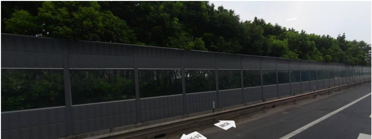
图 7.1-1c 现有绕城高速声屏障防噪措施（绕城主线靠融创河滨二期段）
