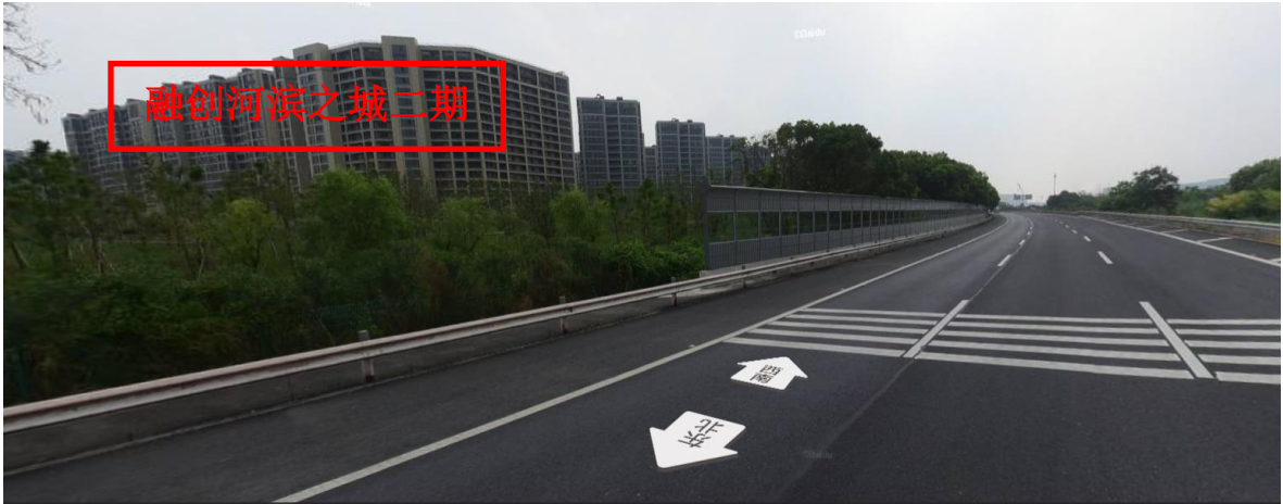
图 7.1-1b 现有绕城高速声屏障防噪措施（互通匝道靠融创河滨二期段）
