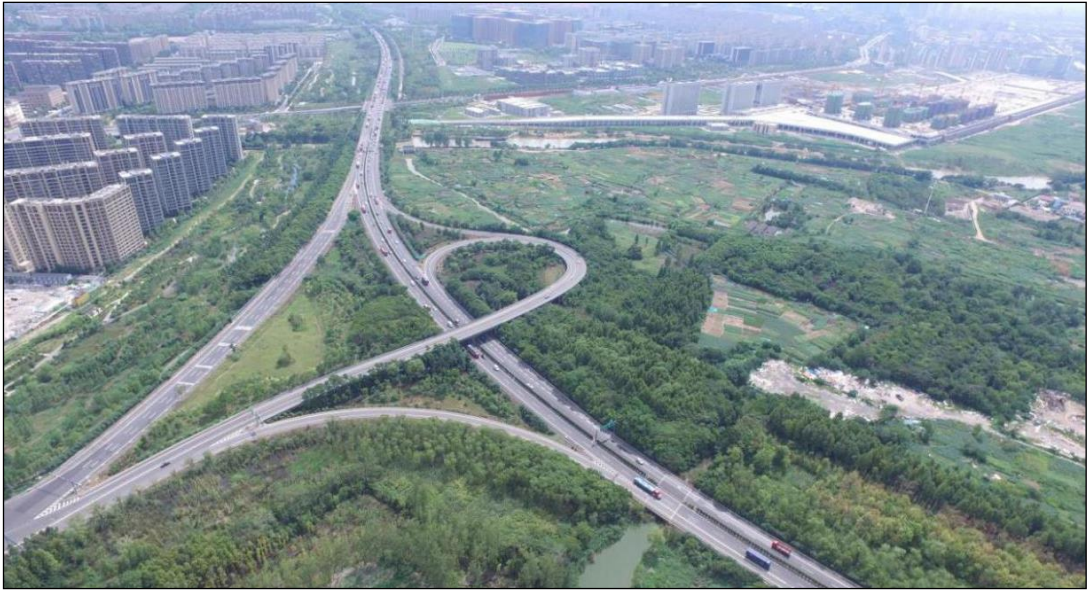
图3-2 三墩互通现状
