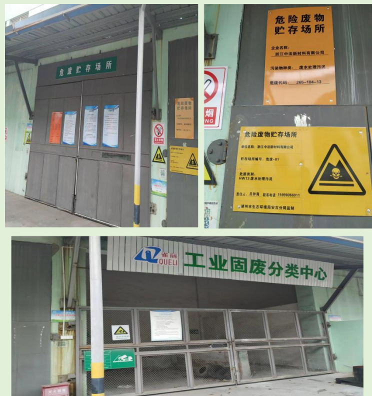
图 3.7-2 现有企业固废暂存设施
