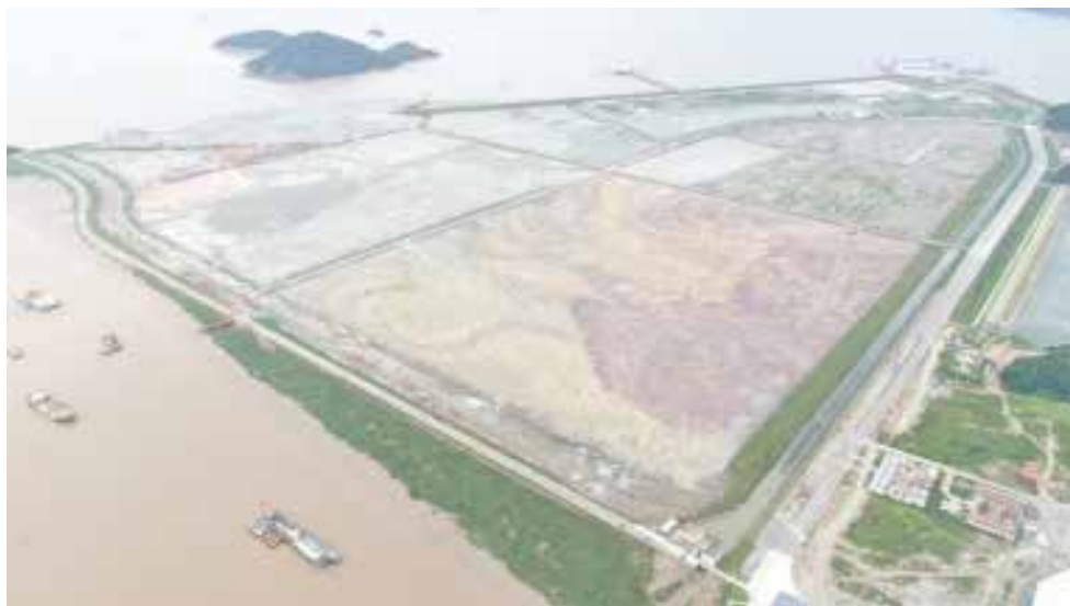
图 4.2-1 东厂区地形地貌
